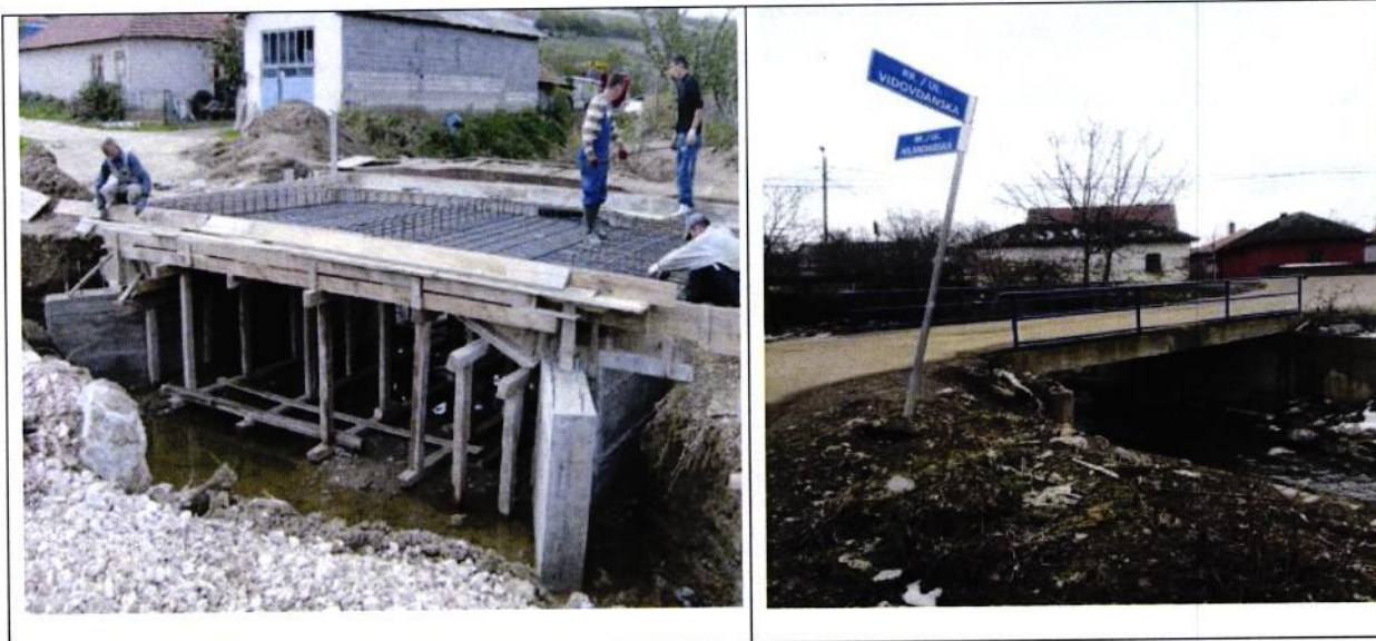
Слика: Мост у ГорњојГуштерициДоњојГуштерици
