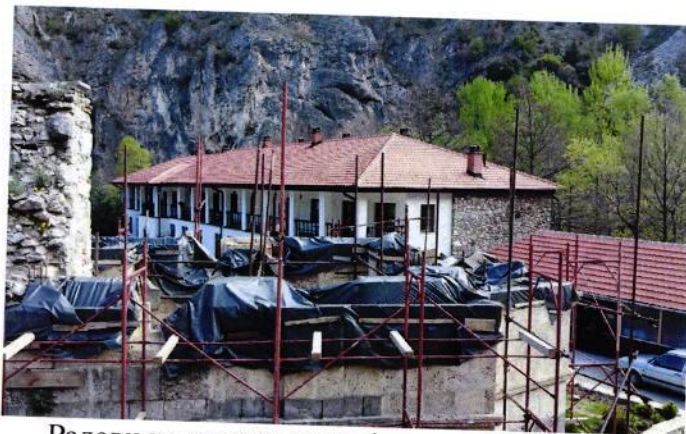
Радови на реконструкцији цркве Св. Николе
